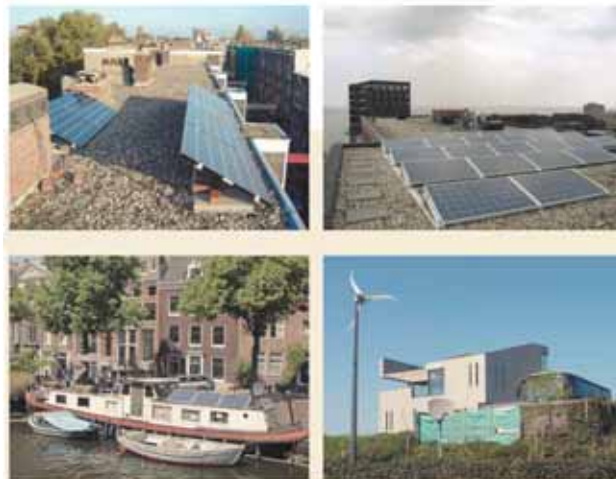
Fig. 2: Diverse realizzazioni di produzione di energia alternativa nel territorio della Municipalità. In senso orario: pannelli solari collocati sul tetto di un'abitazione privata ad Amsterdam East; un sistema di pannelli solari comunali realizzati a IJburg sull'edificio della Homeowners Association; un turbina a vento privata nel suburbio di Osdorp; pannelli solari sul tetto di una houseboat a
