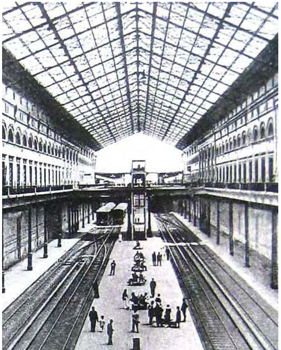
Interno della Stazione Centrale (demolita nel 1957) con la copertura in ferro e vetro realizzata su progetto di Alfredo Cottrau (da Alisio, Buccaro, 2000).
