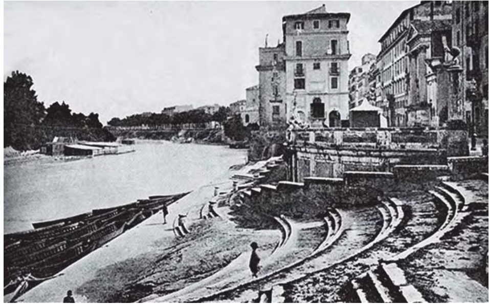
Il porto di Ripetta alla fine dell'Ottocento. La costruzione dei muraglioni lungo il Tevere fu la scelta tecnica fatta per evitare i continui allagamenti della città. L'area nella foto è quella che oggi ospita il museo dell'Ara Pacis di Richard Maier.
