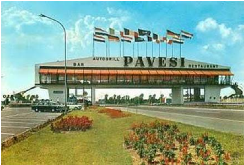
Ideato dall'industriale Mario Pavesi, il primo autogrill a ponte d'Europa fu costruito nel 1959 a Fiorenzuola d'Arda, proprio sull'autostrada del Sole.
