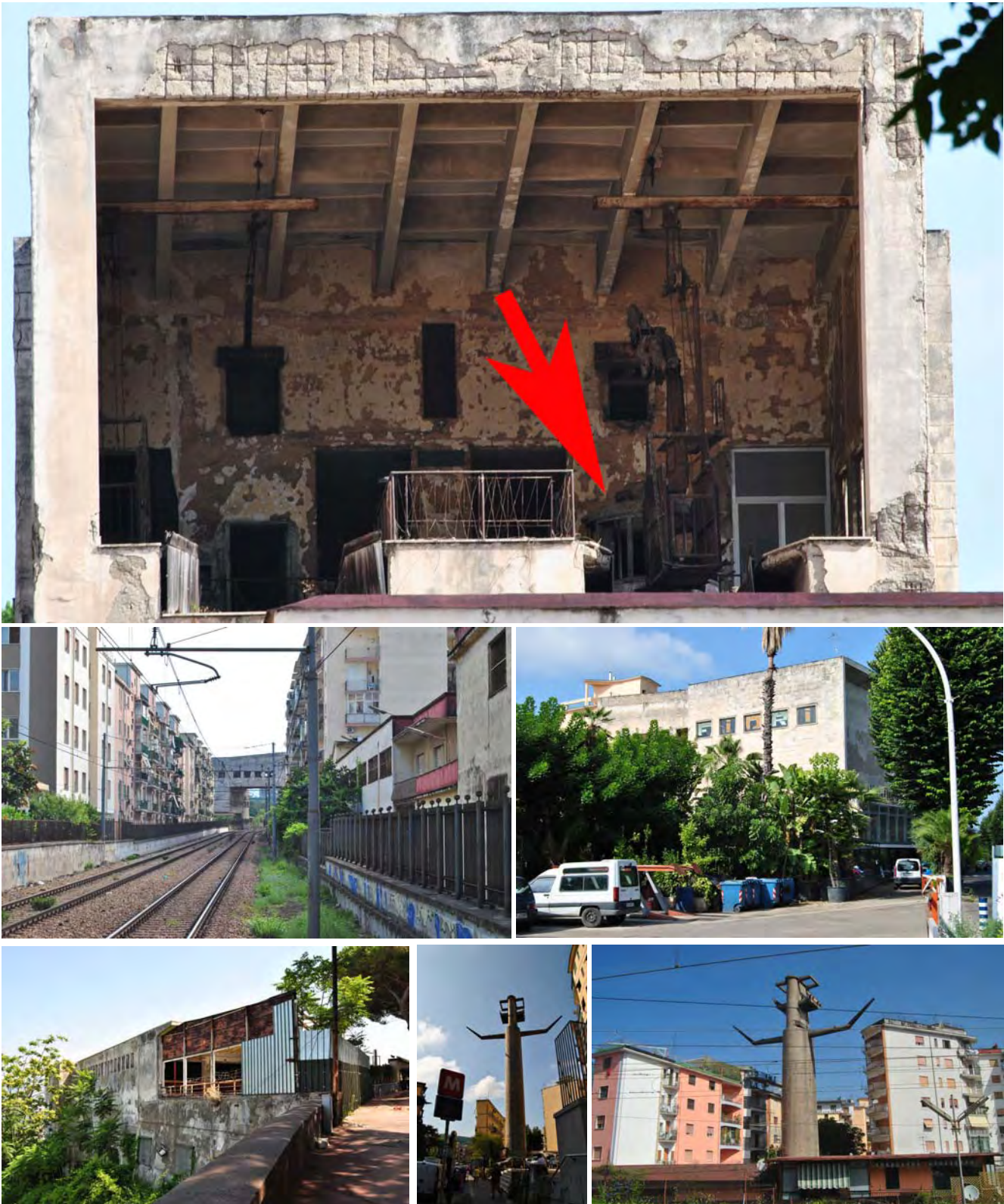
Le immagini dell'impianto funiviario di Napoli (scattate nel luglio 2010), attualmente dismesso ed abbandonato, che collegava il quartiere di Fuorigrotta all'area collinare di Posillipo. Nella foto in alto, indicata dalla freccia rossa, è possibile scorgere la vecchia cabina ancora all'interno della diroccata stazione di valle. Nelle immagini centrali a sinistra ancora la stazione di valle (attualmente sede di un negozio di fiori). Nelle foto in basso la stazione di monte e le imponenti sagome dei piloni di rinvio lambiti dagli edifici.
