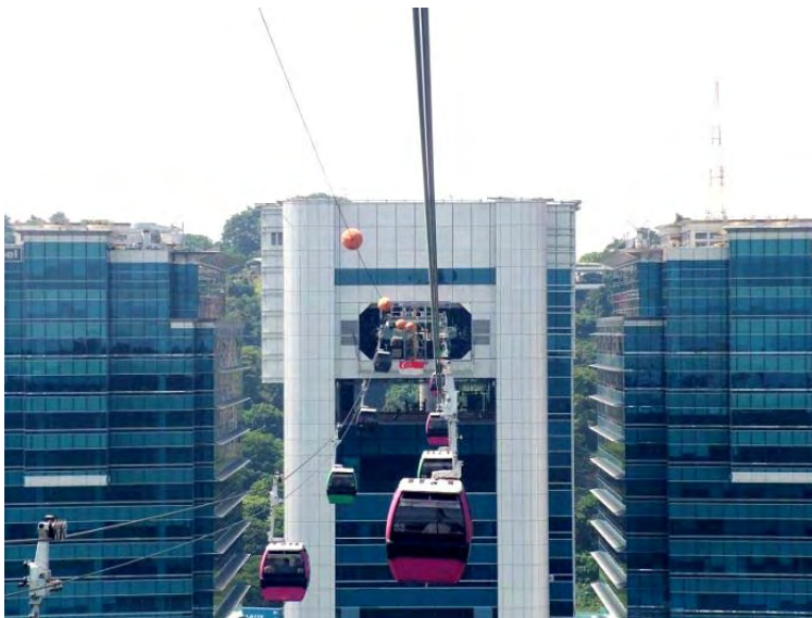
Stazione intermedia della cabinovia urbana "2S" di Singapore che collega il Mont Faber all'isola di Sentosa.
