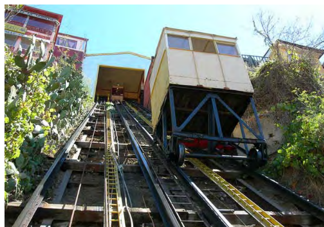
Ascensore: "Espíritu Santo" a Valparaiso, costruito nel 1911, consente il collegamento fra la parte alta e la parte bassa della città cilena.
